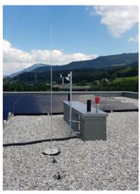
Teilweise sorgt nicht eine Blitzschutzfachkraft für die Einbindung, sondern wird diese durch die Errichterfirma der nachträglichen Dachaufbauten hergestellt – manchmal zu wenig bedenkend, dass dieser Anschluss möglicherweise nicht normgerecht ist und damit eine Haftung im Schadensfall mit sich bringt.
